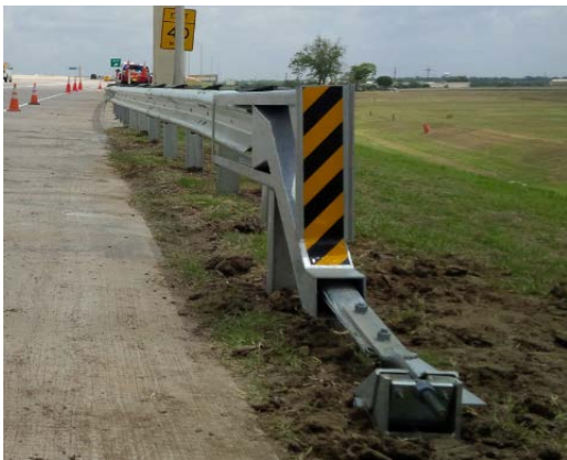
SoftStop™ W-Beam End Terminal (US photo)
