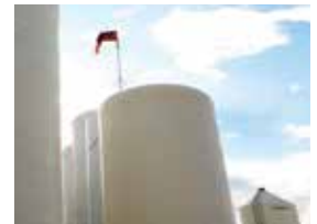
Surveillance de réservoir
