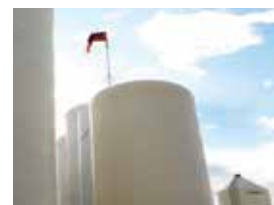
Отслеживание уровня в баке
