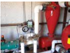
Irrigação por gotejamento
